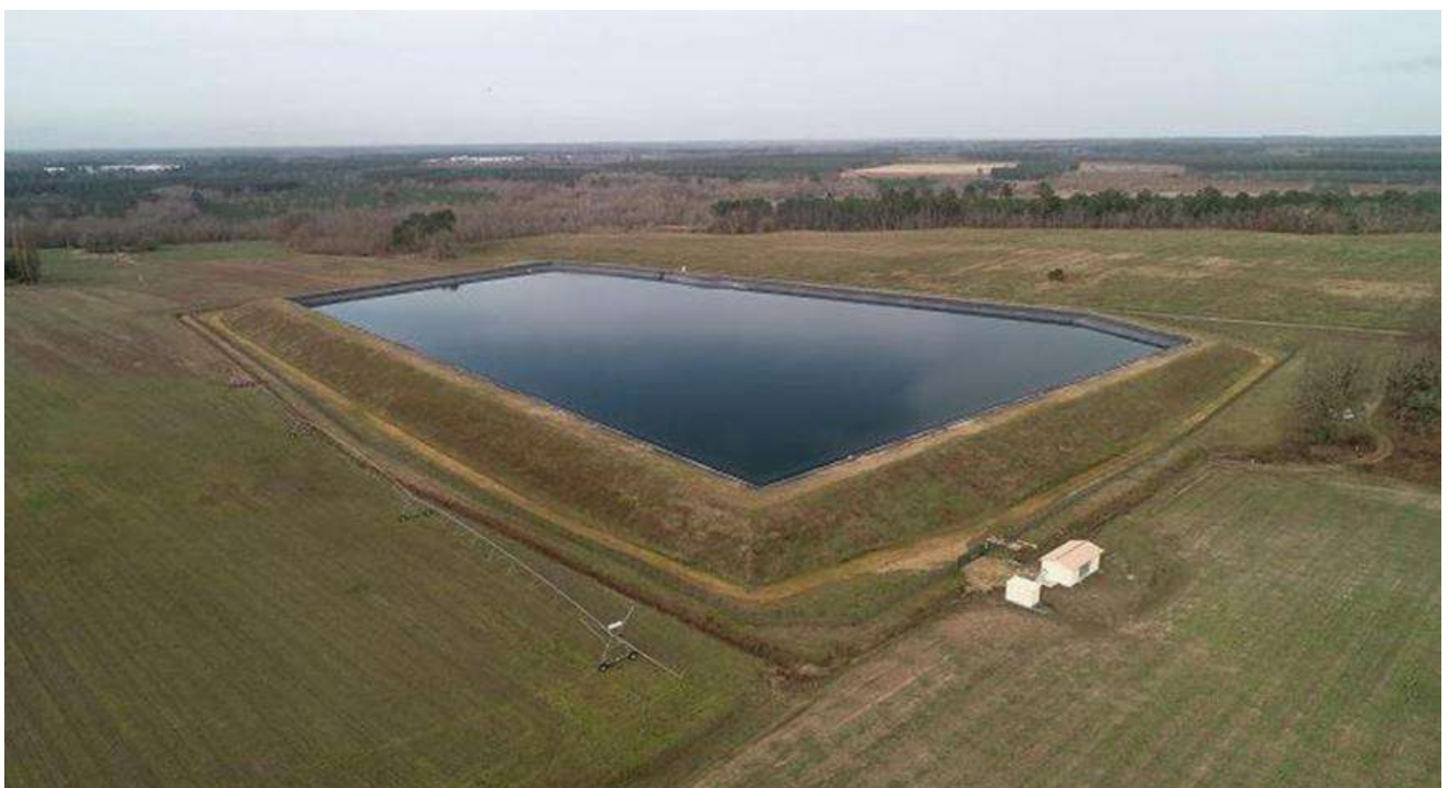
Photo du bassin de stockage à Mazerolles
