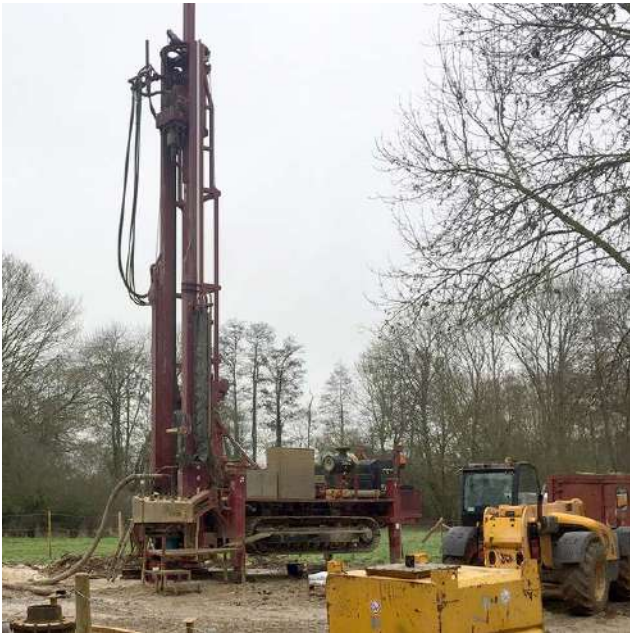
Vue d'une unité de rechemisage d'un forage
