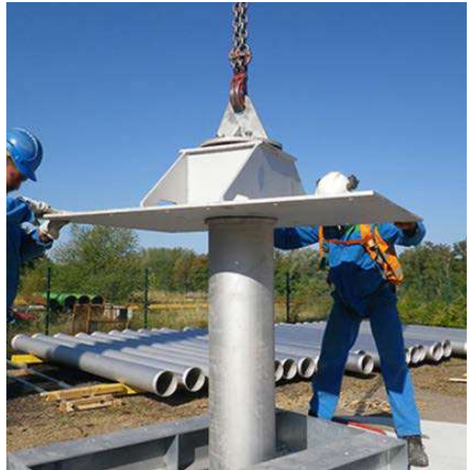
Vue d'un rechemisage d'un forage
