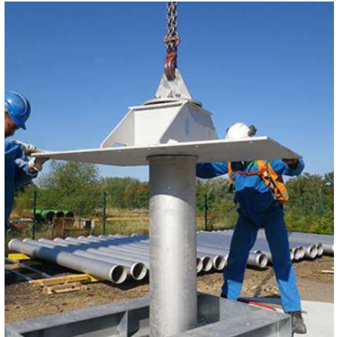
Vue d'un rechemisage d'un forage
