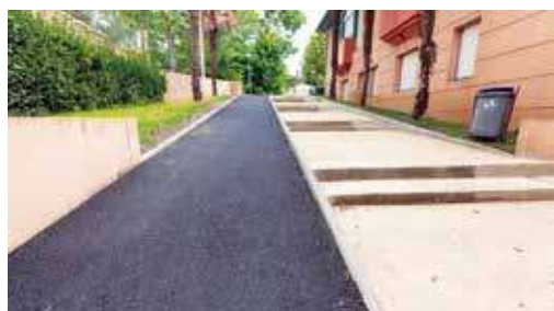
▲ Rampe cyclable quartier des Arènes
