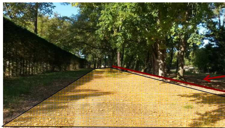
Accès chantier avec portail et clôture
