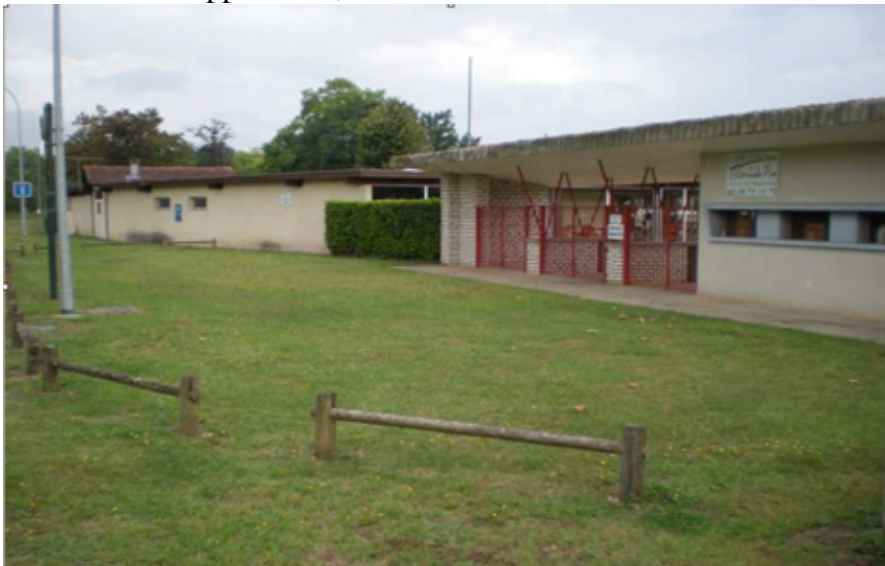
Entrée de l'hippodrome, avant travaux
